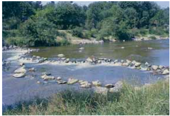
Abb. 4: Das Absturzbauwerk / an der Mangfall / Obb. ist durch eine aufgelöste Kaskadenrampe ersetzt worden.
