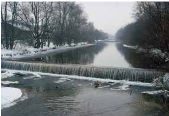
Abb. 3: Absturzbauwerk / an der Mangfall / Obb. im Unterlauf des ausgebauten Wildbachs beeinträchtigt die biologische Durchgängigkeit.
