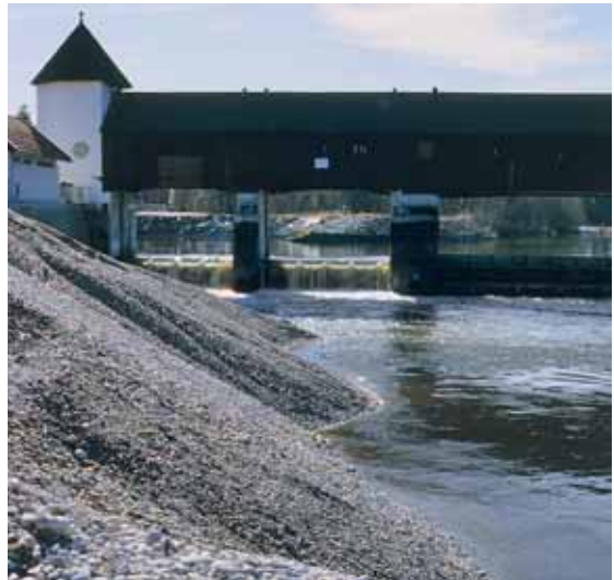
Abb. 5: Isar, Ausleitungwehr Mühlal / Straßlach / Obb. ; das in den Kanal verfrachtete Geschiebe wird im Unterwasser der Wehranlage wieder in das Flussbett eingebracht.
