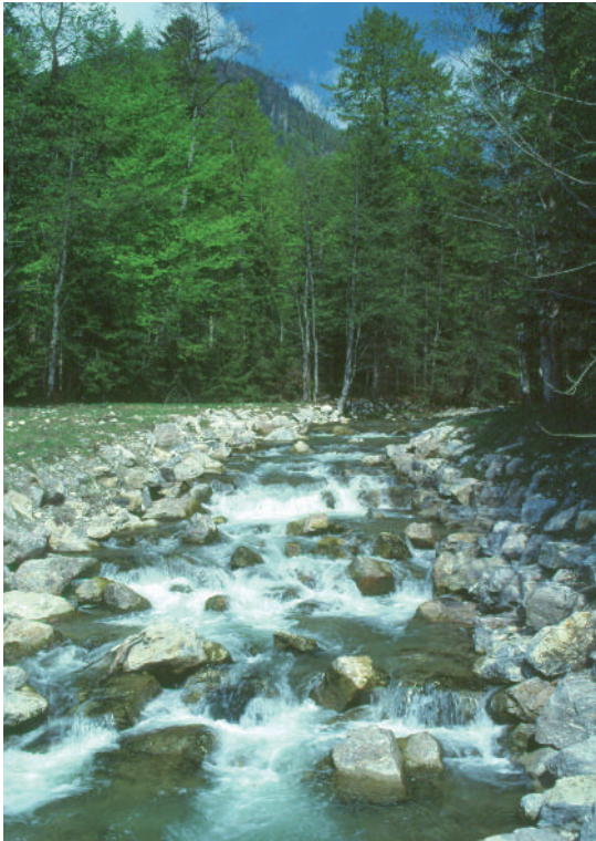
Abb. 9a und 9b: Naturnaher Wasserbau am Beispiel des Wildbaches Schwarzenbach/Gemeinde Kreuth/Obb. oberhalb der Weißach-Klamm vor und nach der Maßnahme. Die unpassierbare Wildbachsperre wurde in eine naturnahe Sohlrampe umgebaut zur Verbesserung der Durchgängigkeit und des Angebots an Lebensräumen im Gewässer; Planung und Bauausführung durch das Wasserwirtschaftsamt Rosenheim, Flussmeisterstelle Miesbach. (Fotos: H. Barnikel, 1987 und nach 1990).
