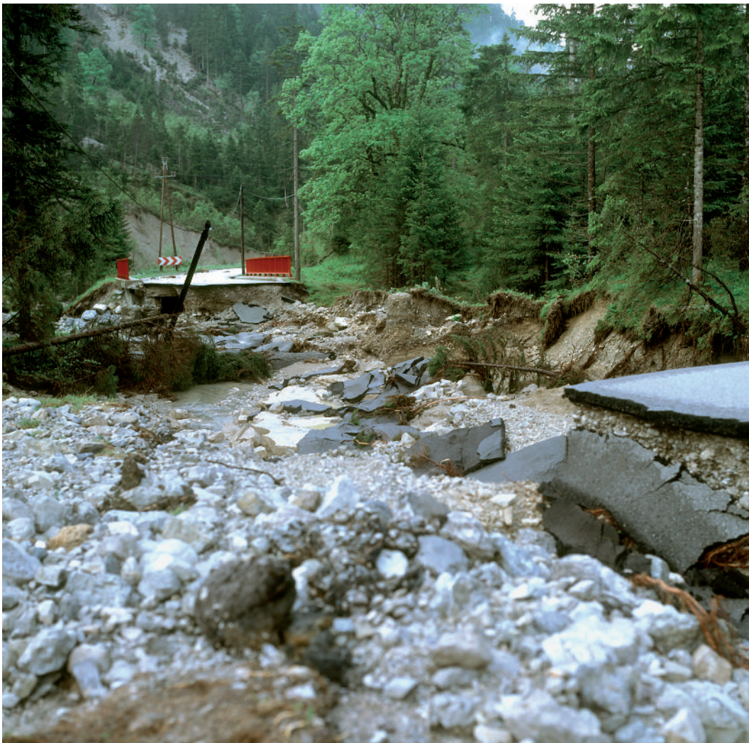
Abb. 5: Wildbachprozess "Hochwasser". Hier weggespülte Straße bei Ammerwald/Ammergauer Gebirge nach Hochwasser. (Foto: Th. Schauer, 29.5.1999).
