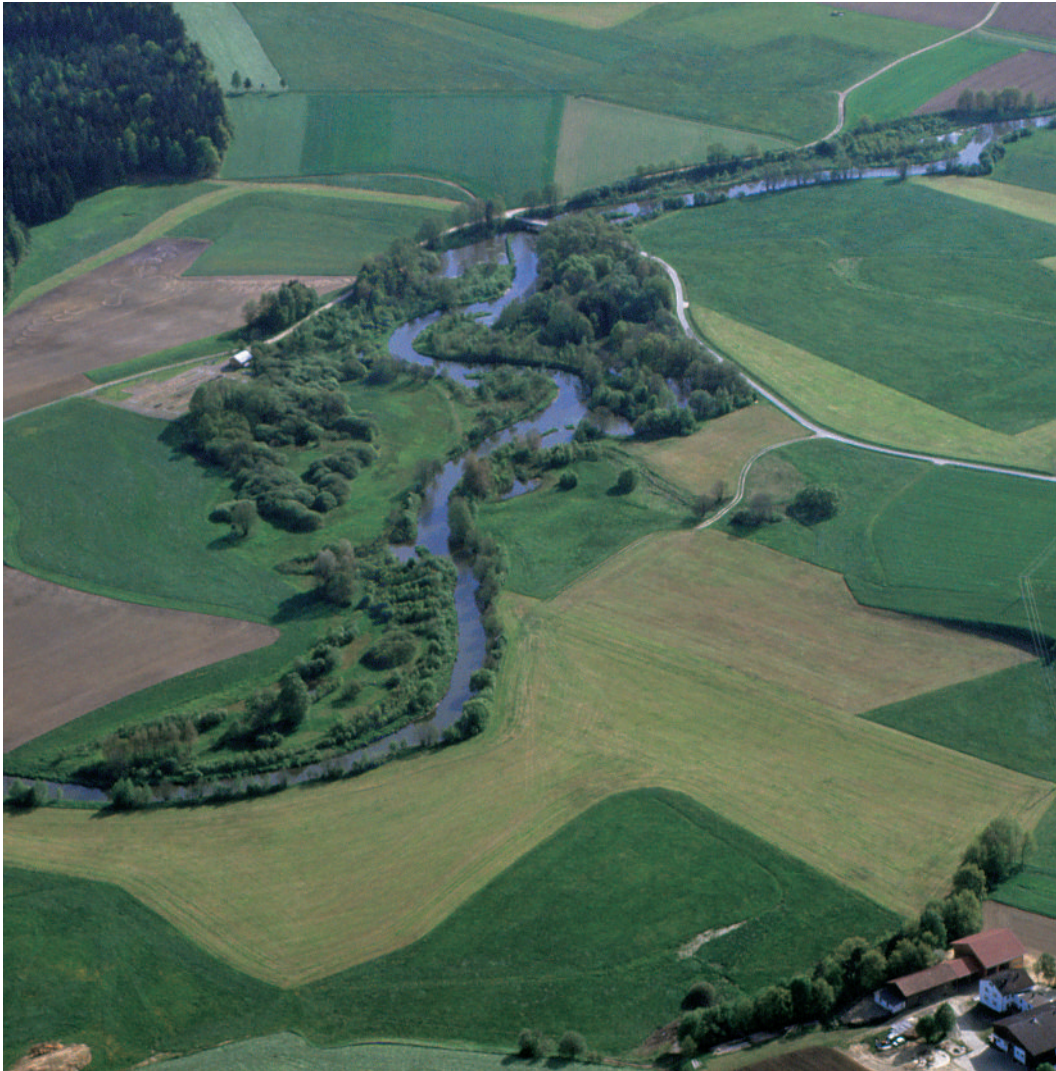
Abb. 7: Ökologischer Ausbau der Schwarzach/Oberpfalz 1986. Voraussetzung für den naturnahen Wasserbau und eine naturnahe Entwicklung von Gewässern sind Flächen, die dem Gewässer belassen oder wieder zur Verfügung gestellt werden können. In den Jahren nach 1980 bis heute wurden zahlreiche ökologische Ausbauten an größeren Fließgewässern in Bayern durchgeführt. Grundlage für den Ankauf solcher Flächen waren Gewässerpflegepläne, heute Gewässerentwicklungspläne. (Foto: W. Binder, 1986/Archiv Bayer. Landesamt für Umwelt).
