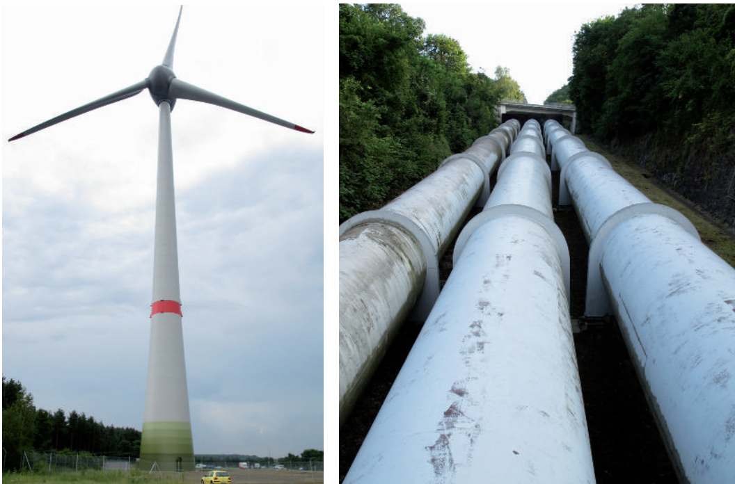
Abb. 6 und 7: Das weltgrößte Binnenwindrad am Standort in der Lausitz, Nabenhöhe 138 m, Rotordurchmesser 127 m, installierte Leistung 7,5 MW (links). Druckleitung eines Pumpspeicherwerkes (rechts). Regenerativen Energien gehört die Zukunft. Aber nicht um jeden Preis. Der Mensch ist auch Ästhet, also darf die Schönheit der Landschaft nicht blindlings geopfert werden. (Foto: H. Röhle).
