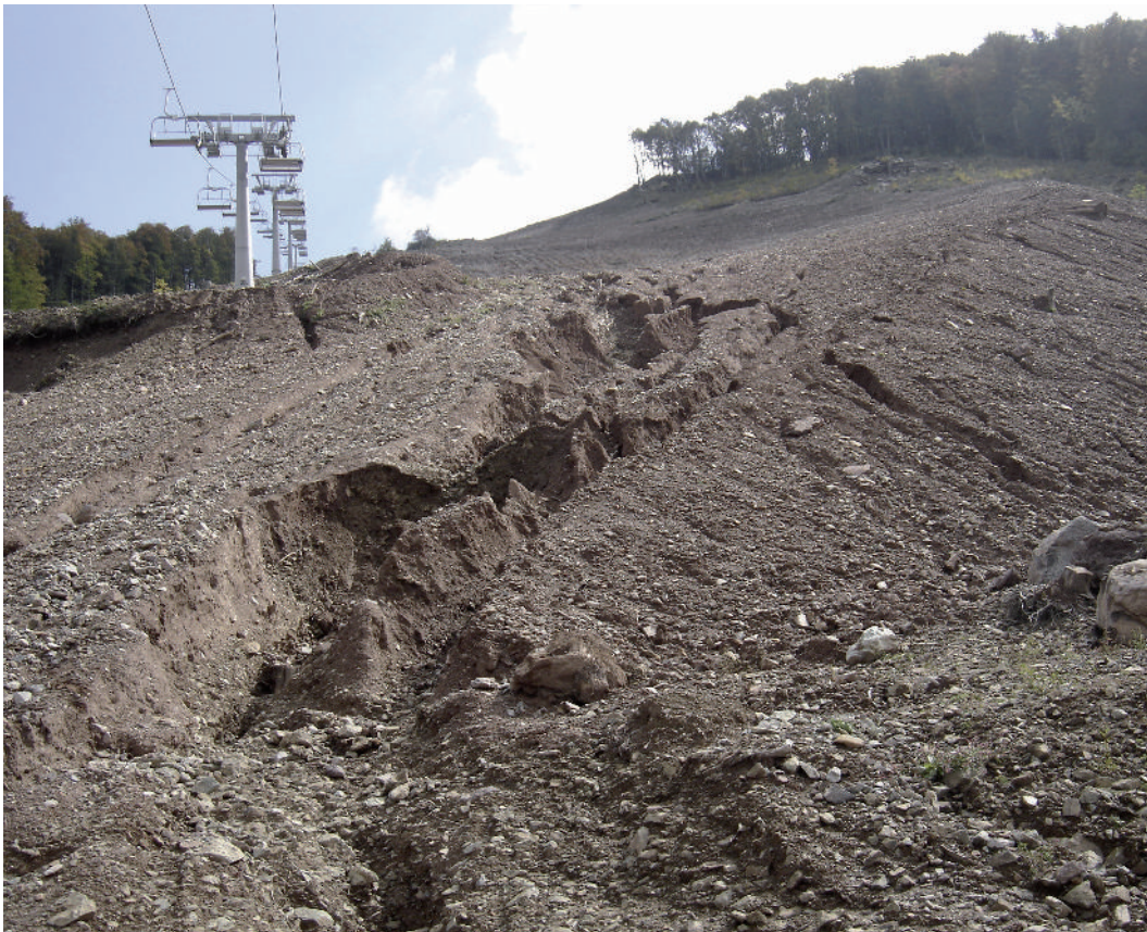
Abb. 16a: Tiefe Gully Erosion (max. 4 m!) auf einer neuen Piste in Konjarnik 2, Stara Planina (1500m ü. N.N.) in Serbien. (Foto: Ristic 2007).
