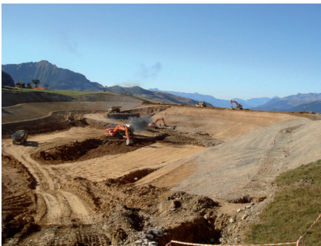
c) Gesamte Dimension des Aushubs des Speicherbeckens.
