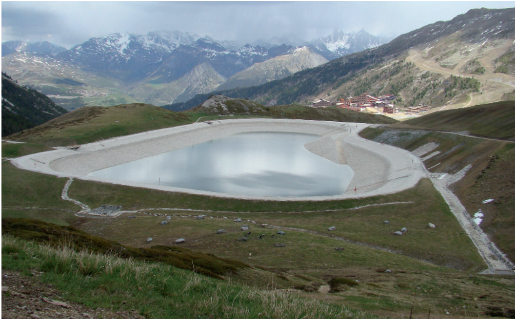
Abb. 6b: Wasserspeicherbecken' Adret les Tuffes (2300 m ü. NN) für die Kunstschneproduktion bei Les Arcs 2000 über Bourg St. Maurice in Savoyen/Frankreich im Monat Mai 2011 während einer langanhaltenden Dürreperiode. Bemerkenswert ist, dass der Speicher mit einem Füllvolumen von 400 000 m 3 auch nach der Schneeschmelze nur zu einem Viertel gefüllt ist (Foto: Carmen de Jong).
