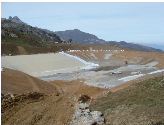
d) Zum Abdichten des Beckens wird undurchlässige Plastikfolie verlegt (alle Fotos von Damelet, 2007).
