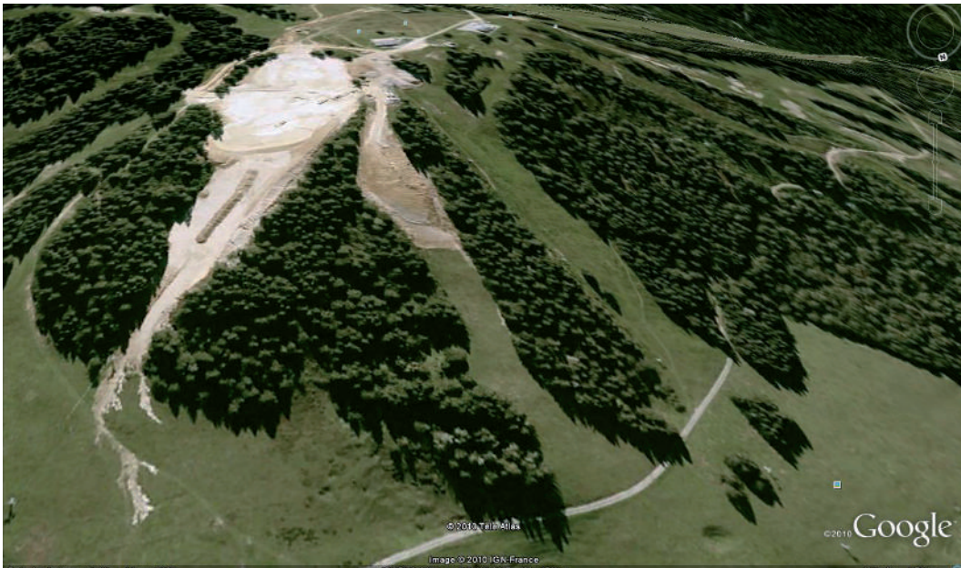
Abb. 17b: Während der Bauphase des Gipfelspeichers zur Kunstschneeproduktion auf dem Mont Lachat nahe Crest-Voland/Hochsavoyen/Frankreich in 1500 m Höhe kam es im Zusammenhang mit einem Starkregen zu einer Mure. Die Sedimente lagerten sich in typischen Loben auf den Almwiesen darunter ab. Die Spuren des Geschehens wurden anschließend weitgehend planiert. (Google Earth Image 2006).
