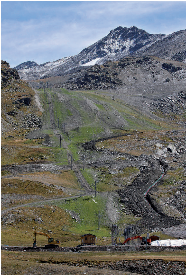
Abb. 10: Umbau alpiner Steilhänge zu Snow Parks im Sommer (hier am Beispiel Val Thorens). Sie wurden entwickelt nach dem Vorbild von städtischen Skateboard-Anlagen. Es wird eine Sequenz von Querwellen mit lokalem Material aufgeschüttet (Bild hinten Mitte). Im Winter müssen diese Strukturen mit großen Schneemengen hochgebaut werden und dazu wird bevorzugt Kunstschnee benutzt. Das Verlegen der Druckluft- und Wasserleitungen für den Kunstschnee ist als dunkles Band im Mittelgrund zu sehen. Diese Kunstlandschaften sind sehr erosionsgefährdet und müssen deshalb mit viel Aufwand von Jahr zu Jahr unterhalten werden. Um die starke Bodenerosion zu mindern, wird ein komplexes System mit tiefen Drainagegräben angelegt. (Foto: Kees Wolthoorn).
