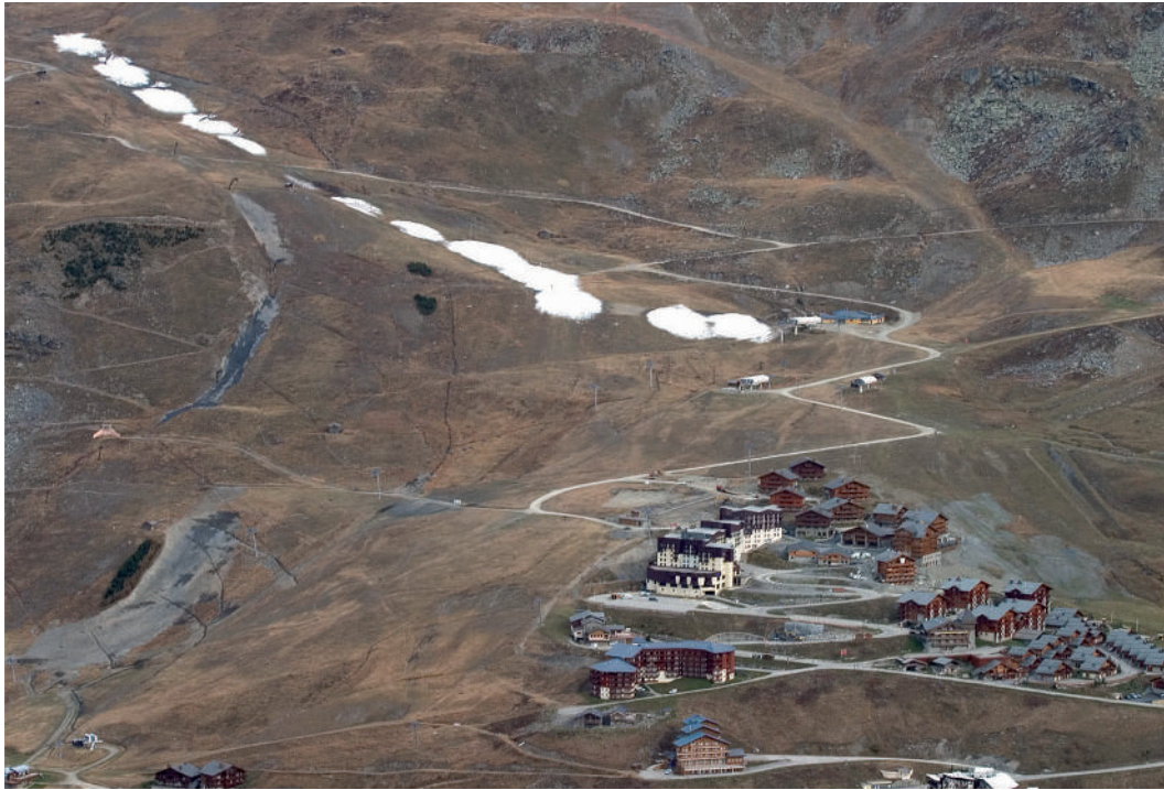
Abb. 17a: Mehrere tiefe Hangrutschungen in Höhen zwischen 1900 und 2100 m in Les Menuires/ Frankreich als Folge der durch den Pistenbau veränderten Topographie und Hangwasserverhältnisse für die steilen Slalom-pisten. Das gesamte Gebiet ist gekennzeichnet durch zahlreiche ältere Hangrutschungen. (Foto: Kees Wolthoorn 2007).
