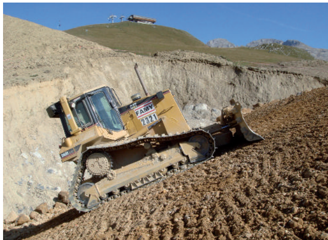
Abb. 7: Bau eines neuen Wasserspeicherbeckens (2007) in Ariondaz (Volumen 125 000 m 3 in 2500 m ü. NN) für die Kunstschneeproduktion auf den Pisten von Courchevel/Frankreich in 2007.
