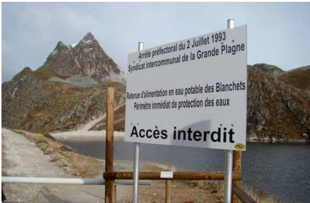
Abb. 16: Aufgestauter natürlicher See Les Planchets (2400 m) zur Trinkwasserversorgung der Skistation La Plagne/Savoien/F in 2400 m Höhe (Foto: de Jong 2011).
