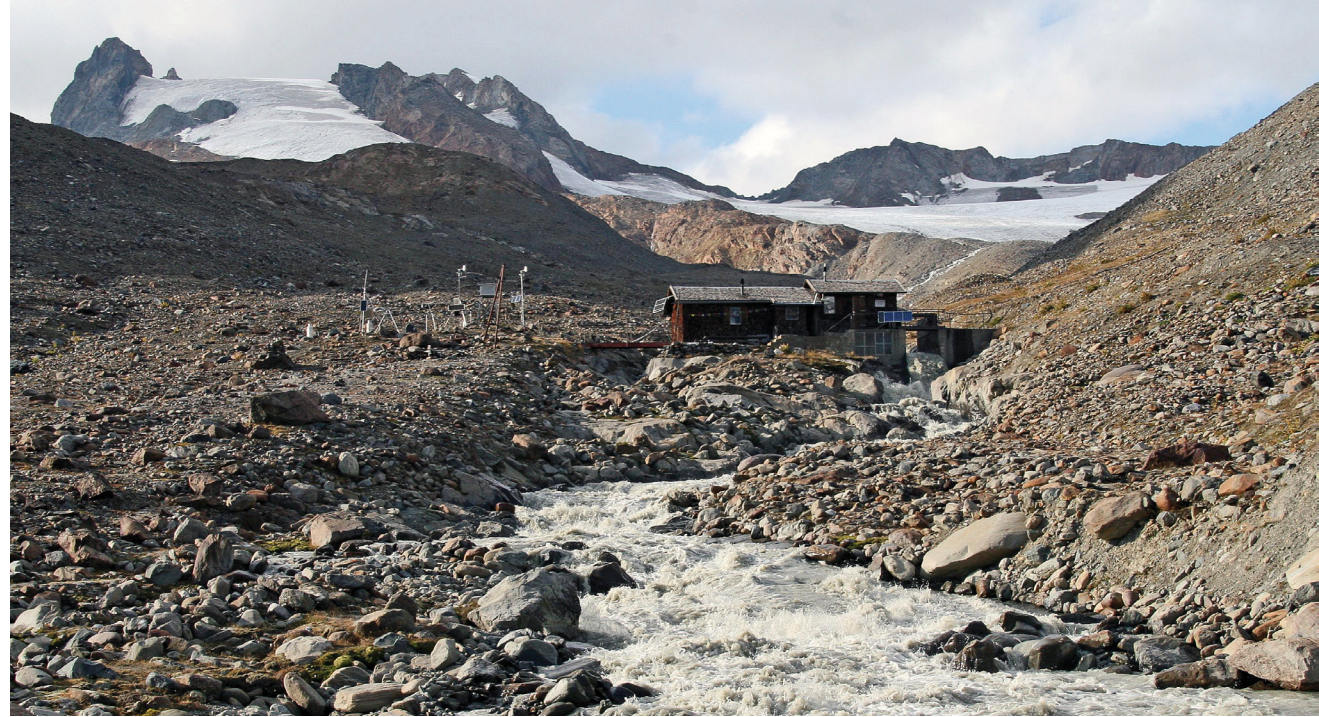
Abb. 14: Die von der Bayerischen Akademie der Wissenschaften betriebene Pegelstation (rechts) und Klimastation Vernagtbach (links) im Vorfeld des Vernagtferners auf 2635 m Höhe. Im Hintergrund die 3535 m hohe Hochvernagtspitze.
