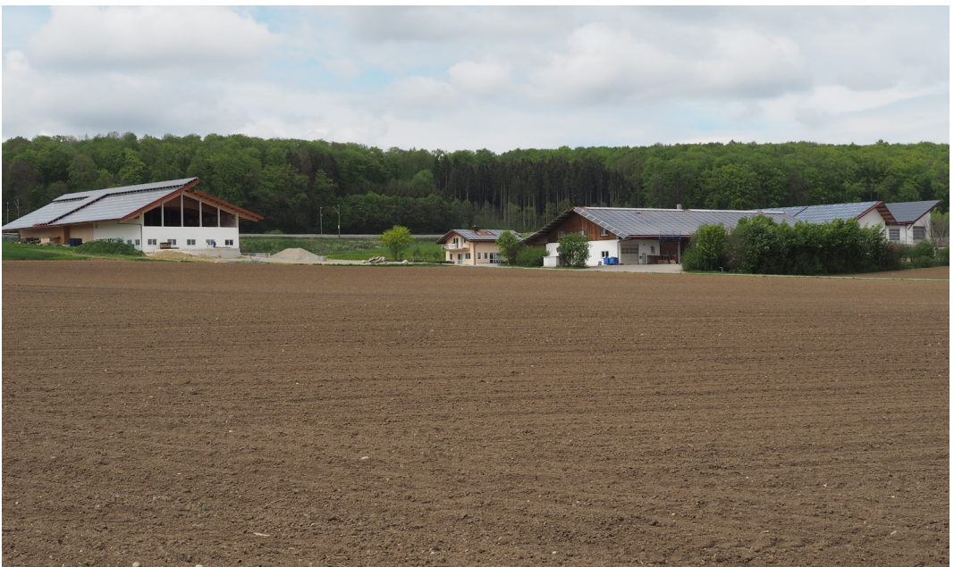
Abb. 2: Noch landwirtschaftlicher Familienbetrieb oder schon Kleinindustrie, die landwirtschaftliche Privilegien ausnutzt? Eine im Außenbereich neu errichtete Hofanlage, die neben landwirtschaftlichen Produkten auch Solarstrom produziert. Das Erscheinungsbild zeigt die systematische Inanspruchnahme von Sonderregeln und Subventionen. Lebensstätten für Insekten und andere wildlebende Arten bietet vor allem der Wald im Hintergrund.
