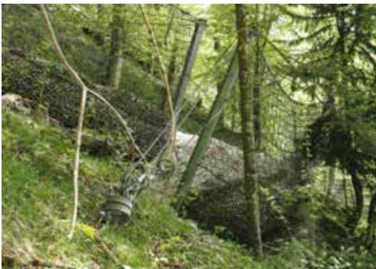
**Abb. 13:** Stahlnetze, oft schon reichlich (hier mit Ramsaudolomit-Schutt) hinterfüllt, sollen die Kunsteisbahn vor Steinschlag schützen. Der Bebauungsplan der Kunsteisbahn endet knapp hinter den Netzen.
