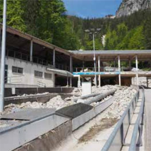
**Abb. 4:** Im Tobel ist die Betonschale der Bahn am 11.05.2022 teilweise geräumt. Über dem Querbau erkennt man die Bahn der Hauptmure.
