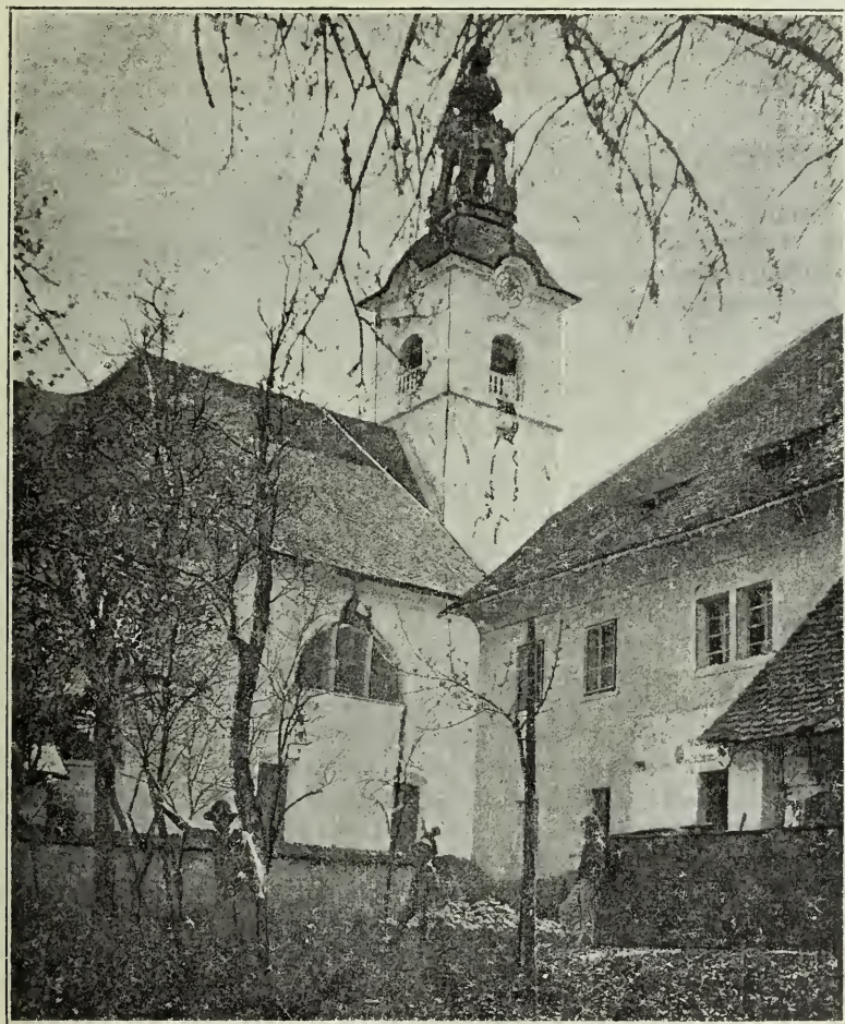
Fig. 38. Kirche von Woditz, Westseite.
