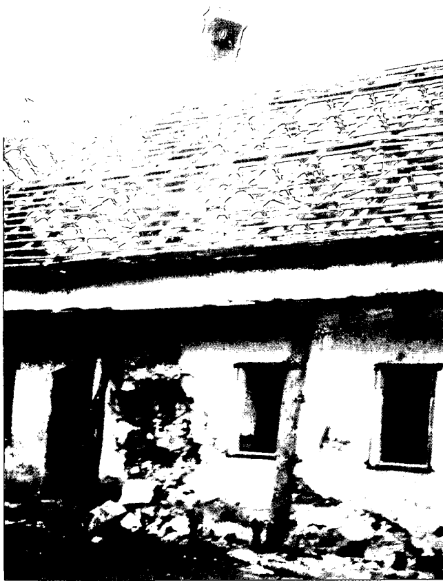
Abb. 44. Rutschung Fischerhof, 1965, zerstörtes Wohngebäude.
