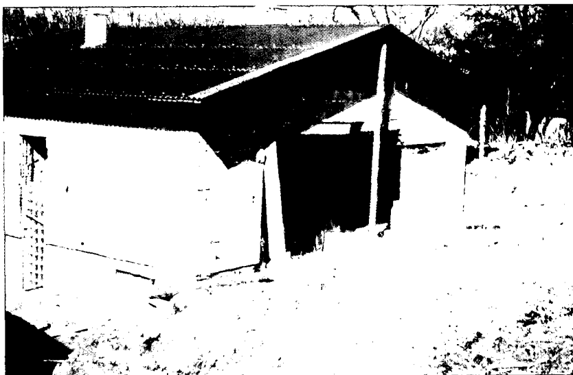
Abb. 52. Rutschung Großweikersdorf, Rückseite des Hauses Nr. 4.
