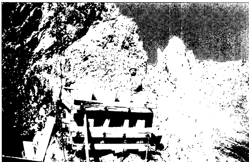
Abb. 20. Lawinsprengseilbahn Kaminspitzen (Nordkette Innsbruck). Horizontal verankertes Stützenfundament im Bau- zustand.
