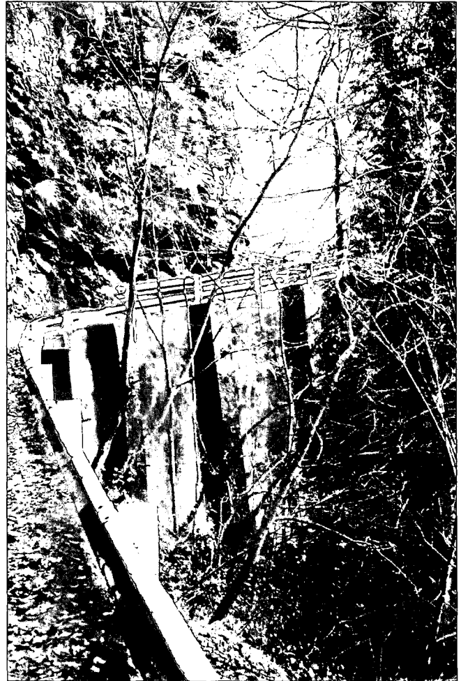
Abb. 8. Meschach-Götzis. Ansicht der Straßenquerung der Meschacher Antiklinale auf der Stützmauer „Fuchsfalle“ nach der Sanierung mit verankerten Lisenen und einer aufgenagelten Baustahlgitter-Spritzbetonschale.
