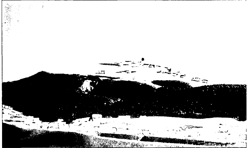
Abb. 10. Sifeler-Weiler/Röthis. Erschließungstunnel vom bestehenden Steinbruch Röthis aus und Kalkgesteinsabbau Etappe I kesselförmig hinter einer Abschirmrippe sowie Endabbauabschnitt II.
