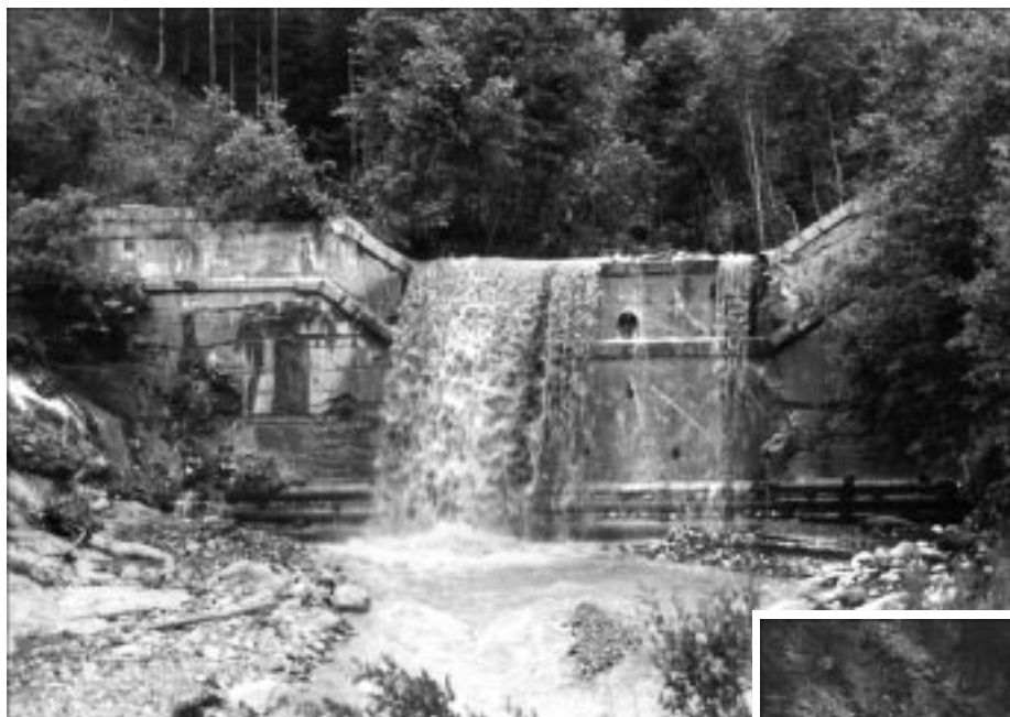
Abb. 15. Holzvorboden, auf dem die alte Sperre aufsitzt.
