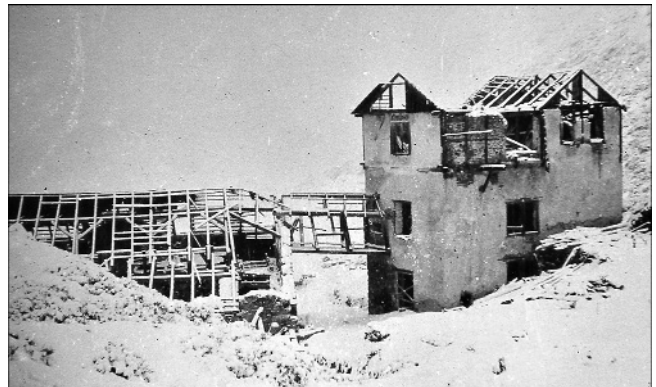
Abb. 7. Ehemalige Aufbereitung (li.) und Talstation der Seilbahn (re.) noch mit Dachstühlen und Verputz. Foto: G. HIESLEITNER (1944).
