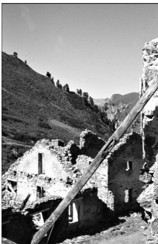
Abb. 9. Gebäudereste der ehemaligen Aufbereitung (Ausschnitt). Foto: F.H. UCIK (1964).
