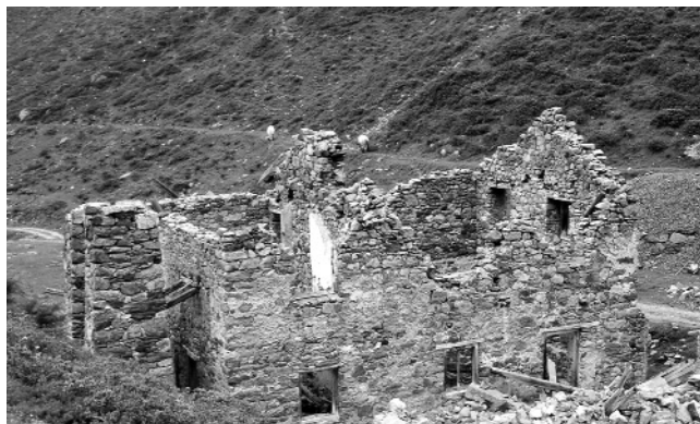
Abb. 13. Ruinen der Aufbereitung. Foto: F.H. UCIK (1987).
