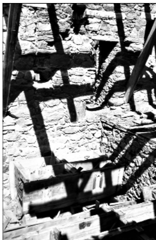
Abb. 10. Schlammtrug; Rest der technischen Anlagen (1987 bereits weg). Foto: F.H. UCIK (1964).
