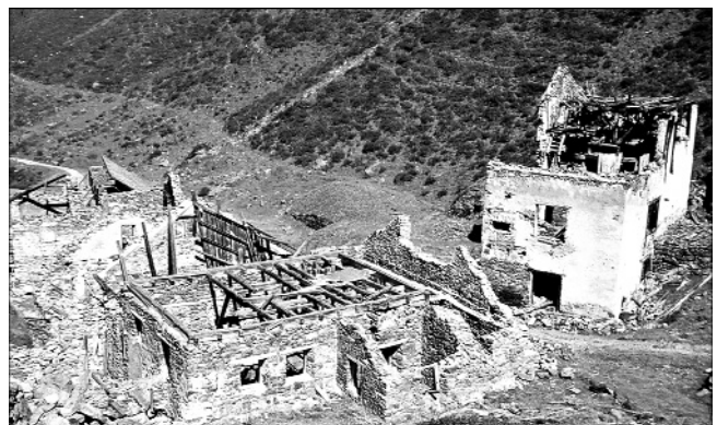
Abb. 8. Ehemalige Aufbereitung (links) und Talstation der Seilbahn; die Gebäude sind bereits teilweise verfallen. Foto: F.H. UČIK (1964).
