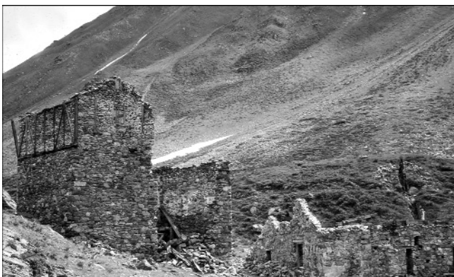
Abb. 11. Talstation der Seilbahn (links) und ehemalige Aufbereitung; die Gebäude sind bereits sehr ruinös. Foto: F.H. UCIK (1987).
