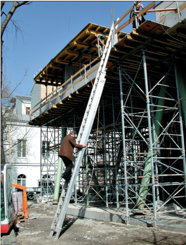
Abb. 9. Hinter dem Leergestell mit dem Obergurt des Raumtragwerks zeigt sich das Gebäude der Bibliothek der GBA.
