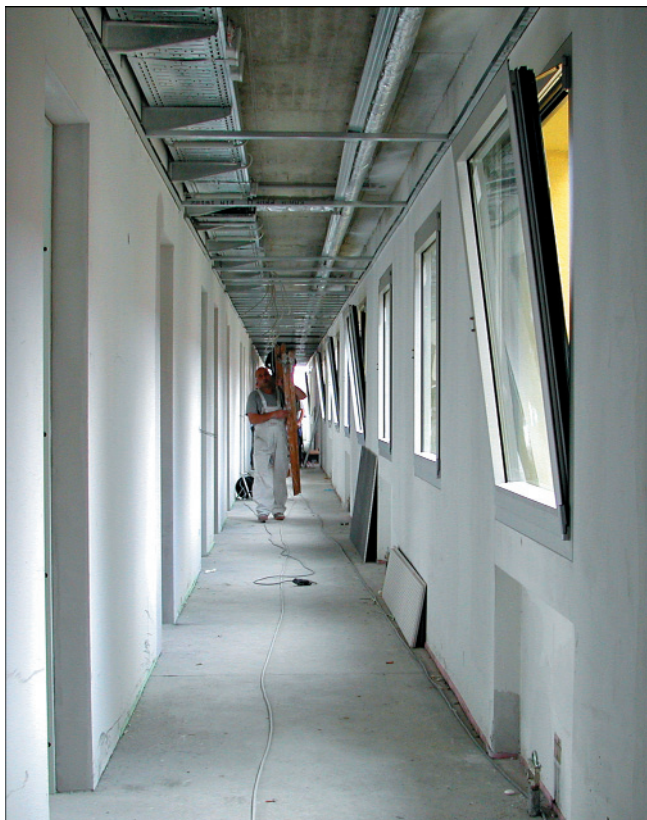
Abb. 18. Der Innenausbau schreitet voran: Blick auf die noch unverkleideten Kabelkanäle an den Gängen.
