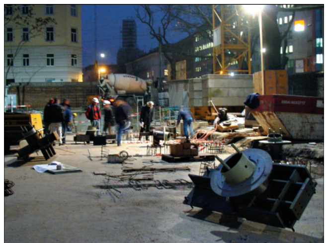
Abb. 14. Bis in den späten Abend wurde gearbeitet: Zwei Fußknoten des stählernen Raumtragwerkes.
