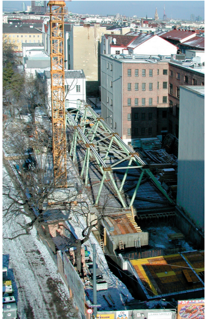
Abb. 13. Das fertige Raumtragwerk des Westtrakts – eine Stelzenkonstruktion – aus der Vogelperspektive.
