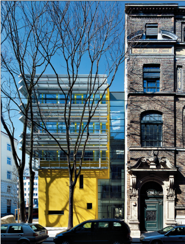
Abb. 7. Der Bau der ehemaligen Druckerei Jasper (Architekt: Julius Deininger, 1892) wird durch ein Glasband mit dem Neubau verbunden.
