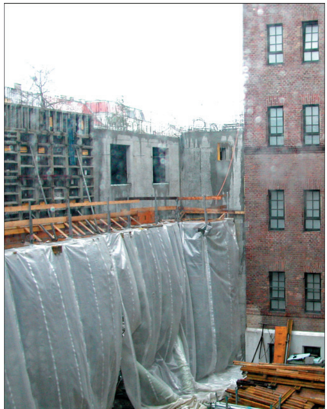
Abb. 16. Nass-trübe Stimmung auf der Baustelle: Blick auf das erste Obergeschoß im Winter 2004.
