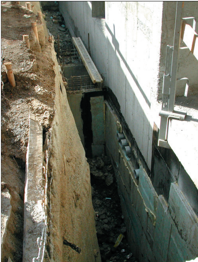
Abb. 12. Blick in den Arbeitsgraben (Südtrakt) mit den Isolierungsmaßnahmen für das Untergeschoß.
