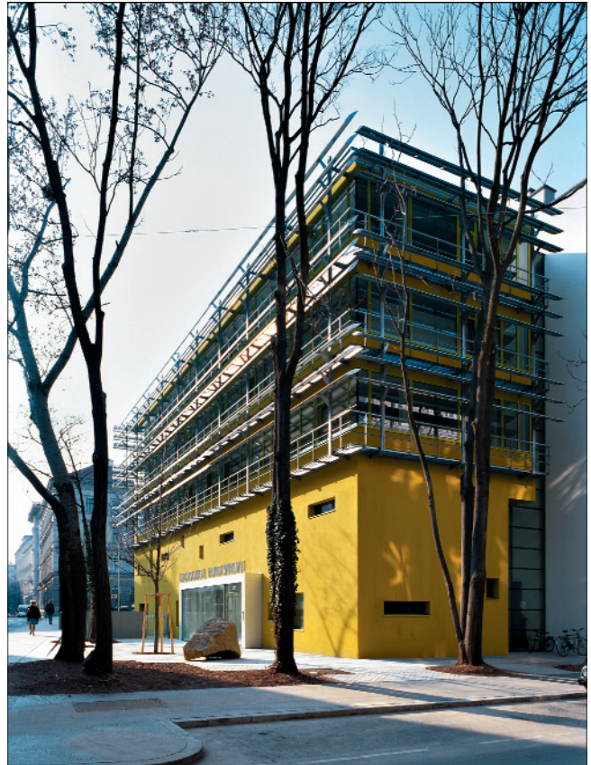
Abb. 8. Auf dem neu geschaffenen Vorplatz dominiert ein Block aus Schärdinger Granit („Geologie zum Ausprobieren“).
