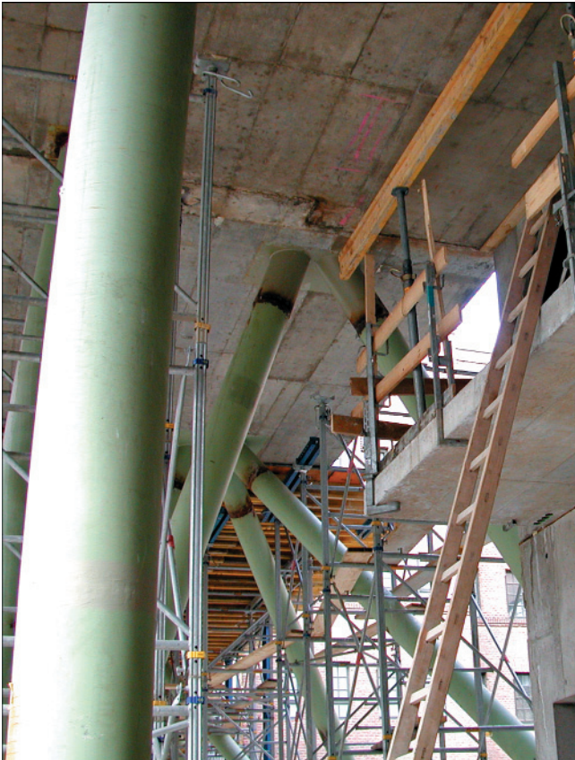
Abb. 11. Blick durch die Stelzenkonstruktion des Raumtragwerks auf das bestehende Laborgebäude.
