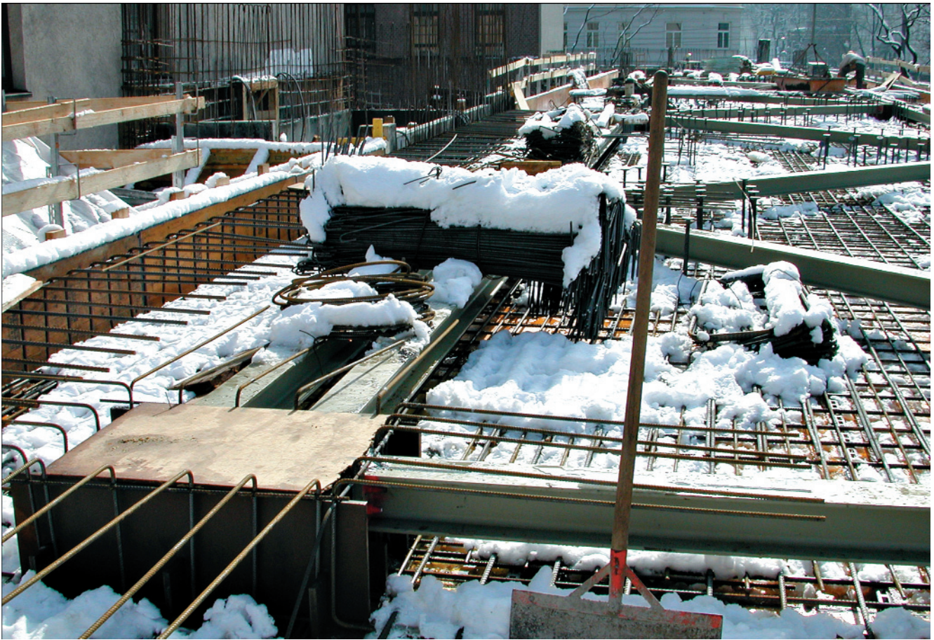
Abb. 15. Trotz starker Schneefälle schreiten die Arbeiten auch im tiefen Winter (2004) voran.
