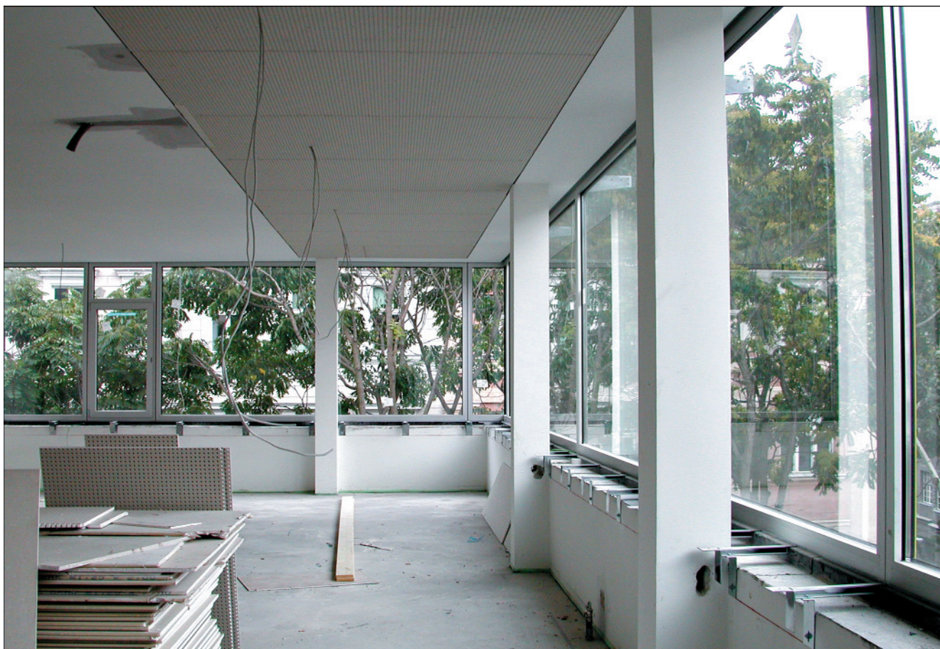
Abb. 17. Montage der Akustikdecken im 3. Obergeschoß.
