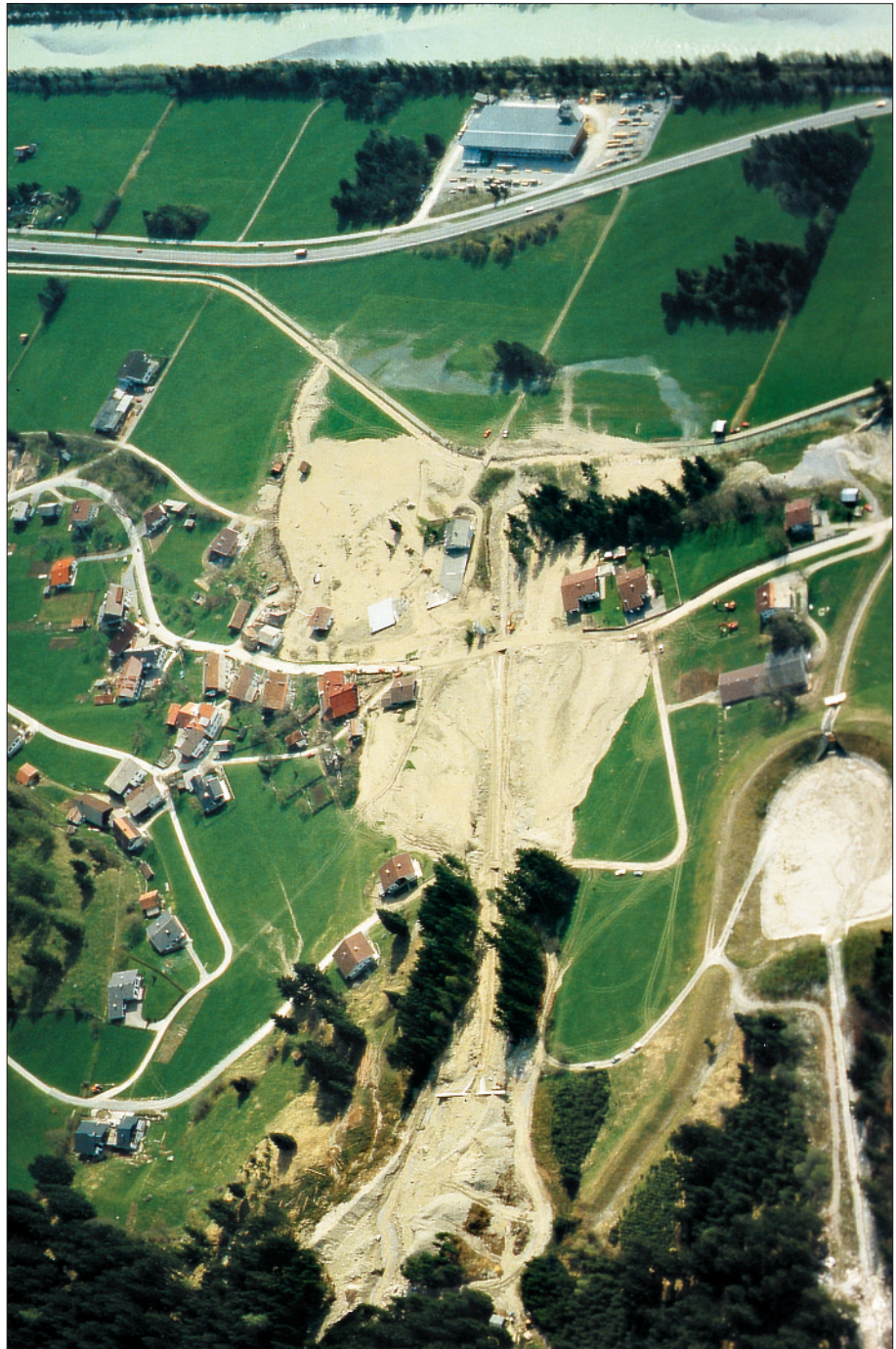
Abb. 1. Mureignis vom 2.–5. Mai 1986 im Murenbach. Am Unterlauf wurden 4 ha landwirtschaftliche Fläche verwüstet. Foto: Dr. DRAGOSITS – Wildbach- und Lawinverbauung, Gebietsbauleitung Außerfern.
