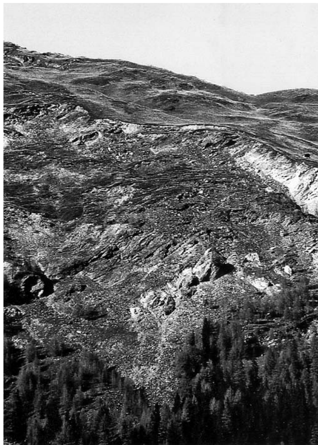
Abb. 10. Blick auf den z.T. in ein Schollenmosaik zerlegten obersten Bereich der Talzuschubsmasse unterhalb der deutlich ausgeprägten Hauptabrissskante.
