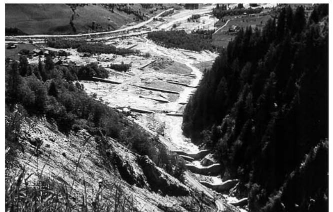
Abb. 2. Blick vom Fuß der Talzschubsstirn auf den Schwemmfächer und der durch die Murenkatastrophe von 1966 zerstörten Ortschaft Putschall. Im Vordergrund sind die nach der Katastrophe neu errichteten Betonsperren.
