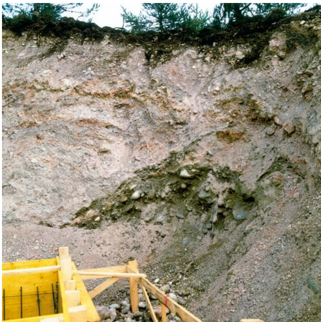
Abb. 9 Aufschluss der Baugrube des Umspannwerkes Haiming. Bergsturzmaterial mit Fließstrukturen und aufgenommenen Innschottern. Foto: 29.10.1992.
