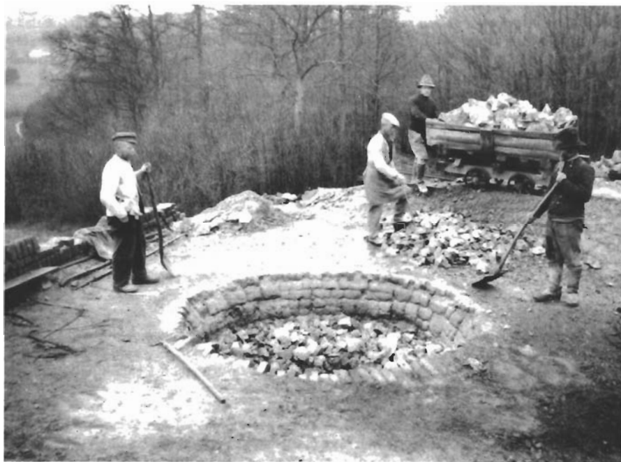
Abb. 35: Beschicken eines Schachtofens mit Kalkstein und Kohle bei Ruppichteroth (Fot. Kreisarchiv Gummersbach).
