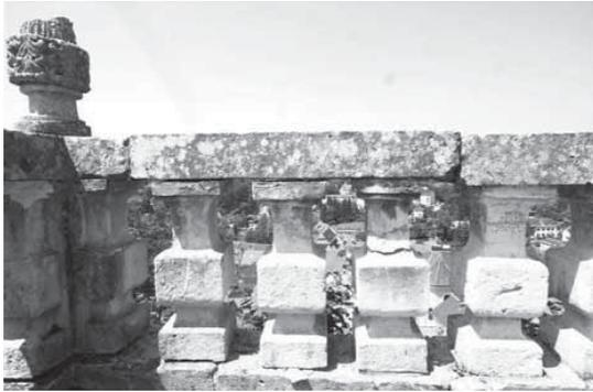
Nach umfangreichen Trassierungsarbeiten in dem ohnehin sensiblen Terrain hatten heftige Regenfälle im Sommer 2007 die Terrasse stark unterschwemmt, sodass die nur mehr lose verfugte Steinschichtung in gefährliche Bewegung geraten war. Die Balustrade an der Vorderseite hatte schon begonnen einzubrechen und abzustürzen.
