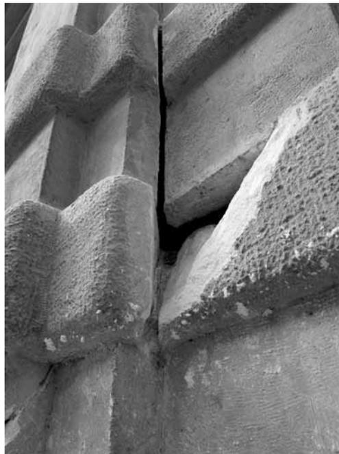
inadäquate Fugenmörtel und Schlämmen früherer Restaurierungen. Dem Verkleben abgenommener Originalfragmente folgten deren Montage mittels korrosionsbeständigen Armierungen und schließlich die Anpassung der Oberfläche an das Gesamterscheinungsbild durch Kalkschlämme. (Rest. Otto BLASSNIG)
