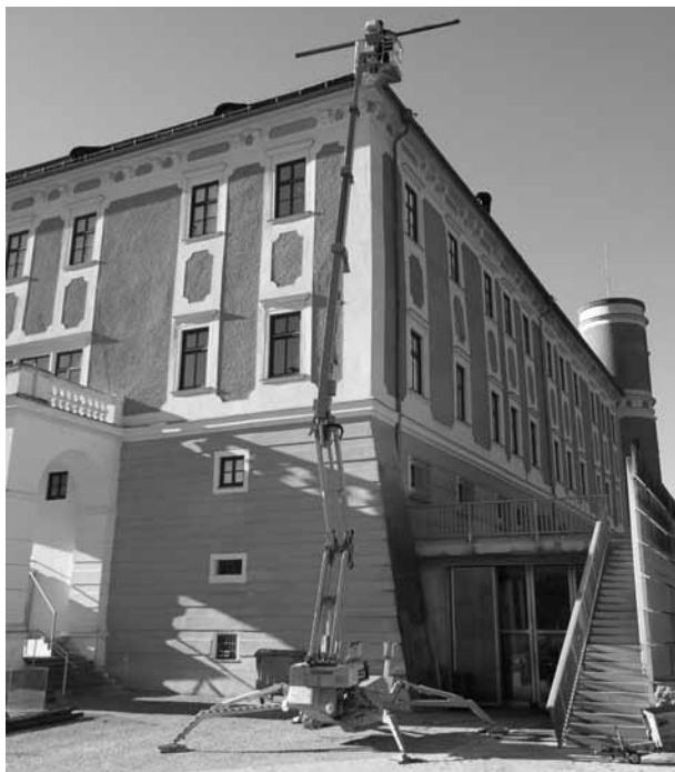
Dachsanierung, Erneuerung der Schneefänger, Foto: K. Krenn
