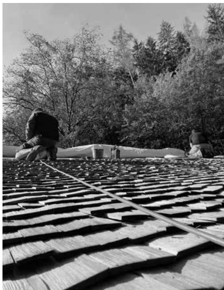
Arbeiten an der Fünffach-Überdeckung des Scharschindeldaches des Bregenzerwälderhauses. Foto: UMJ
