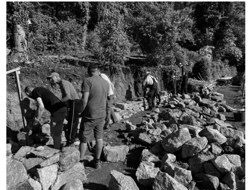
Errichtung der Trockensteinmauer im Bereich der Vorzuchtgärten im Rahmen des Kurses. Foto: UMJ
