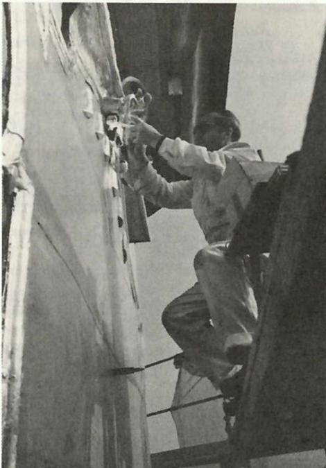
Abb. 1: Vergoldungsarbeiten an den Zifferblättern der Turmuhr
