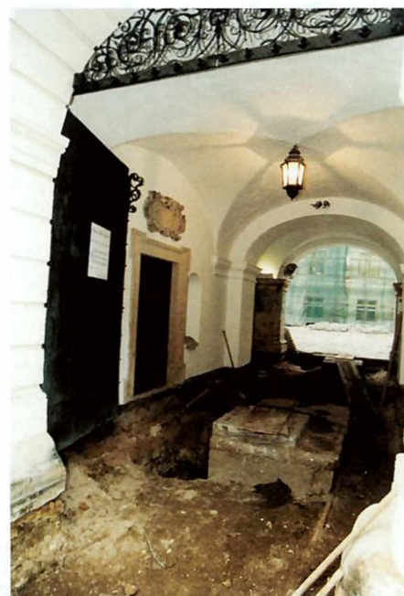
Neuverlegung der Wasserleitung im Einfahrtsbereich
