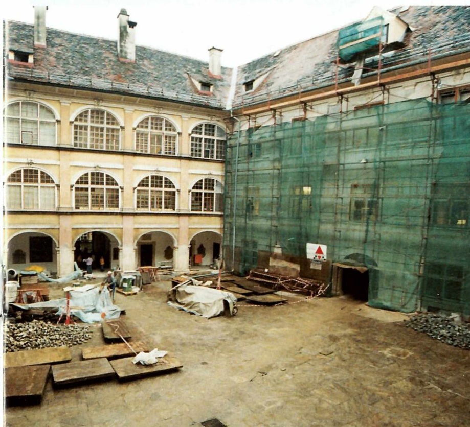
Restaurierung des Hofes Raubergasse 10
