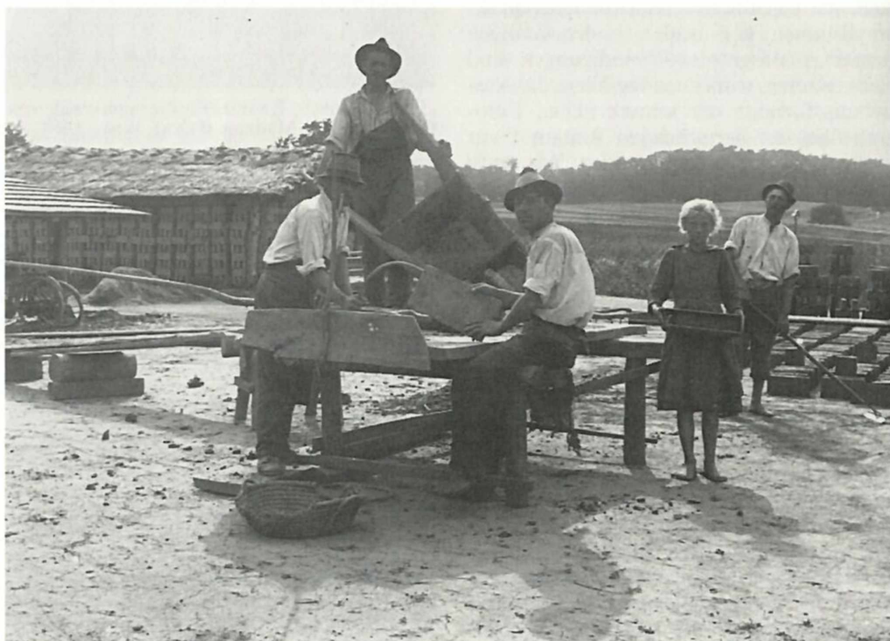
Ziegler bei der Arbeit am Schlagtisch. Der Ziegelstadel von Radkersburg. Foto: LMJ, Bild- und Tonarchiv
