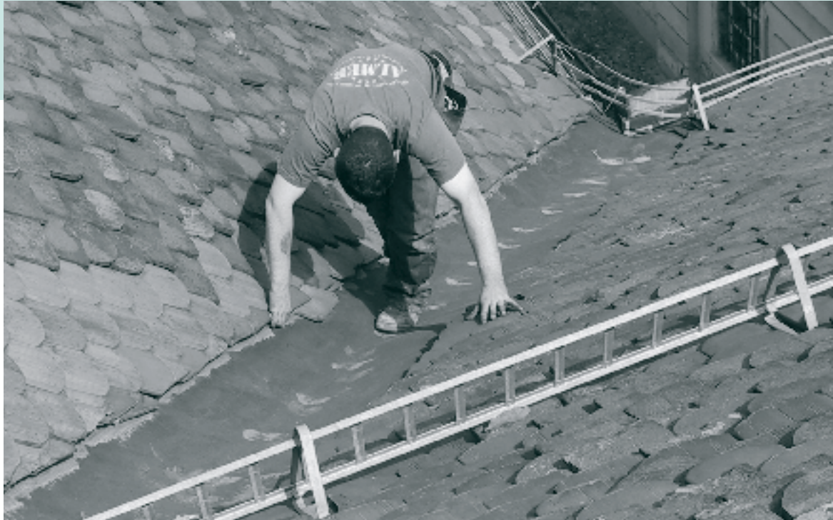
Sanierung der gesamten Dachfläche der Neuen Galerie Graz
