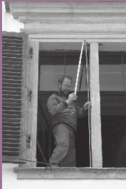
Außenfenster- und Balkensanierung. Schloss Eggenberg
