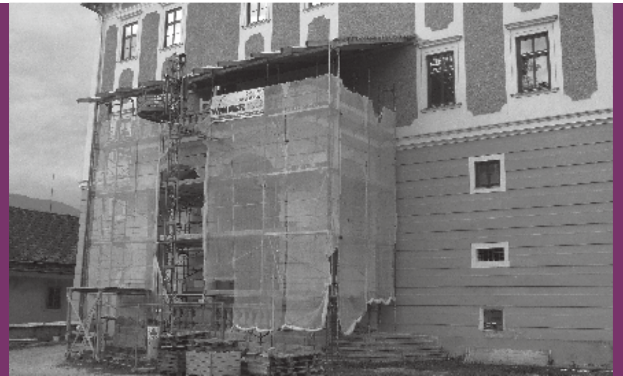
Balkonsanierung. Schloss Trautenfels
