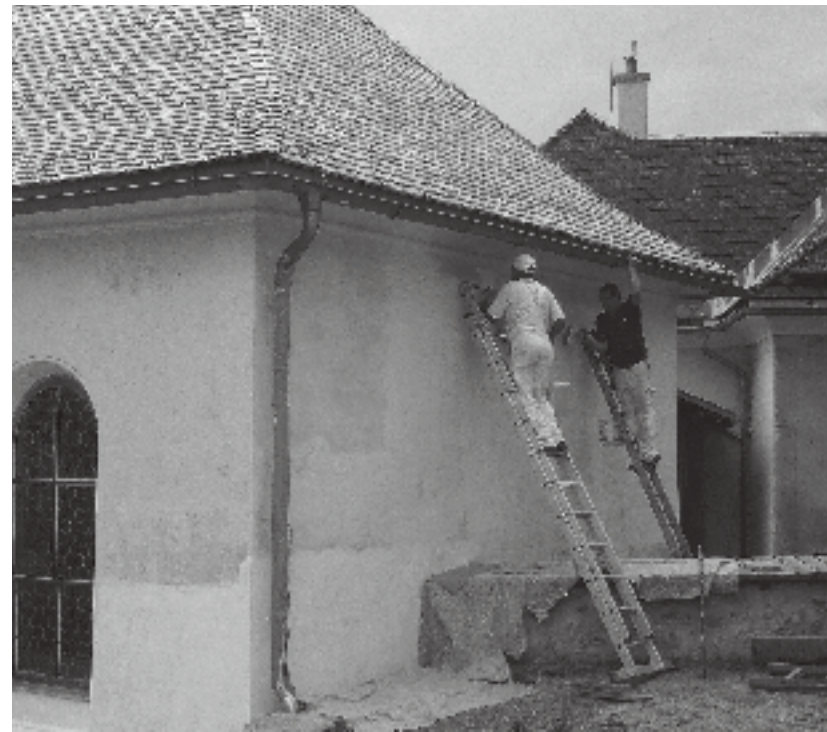
Dach- und Grundsanierung. Schloss Trautenfels, Kapelle
