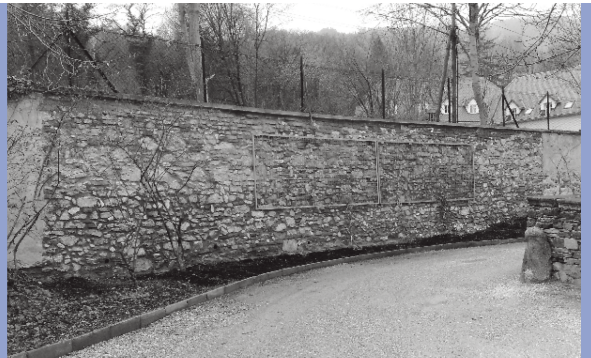
Saniert: die Gartenmauer von Schloss Eggenberg
