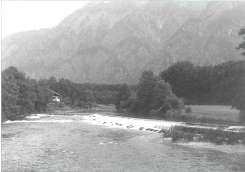
Abb. 4: Der letzte intakte Eispolster der historischen Bauart an der Traun (bei Bad Goisern)
