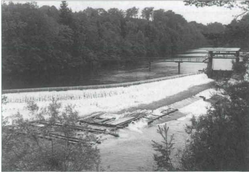
Abb. 6: Floßgasse beim Kraftwerk Kemating
