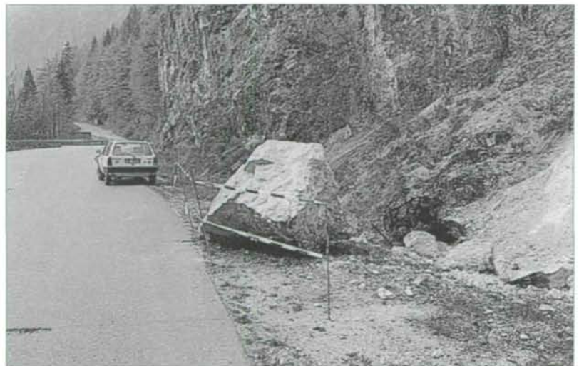
Abb. 2: Auch Steinschlag ist eine große Gefahr.
