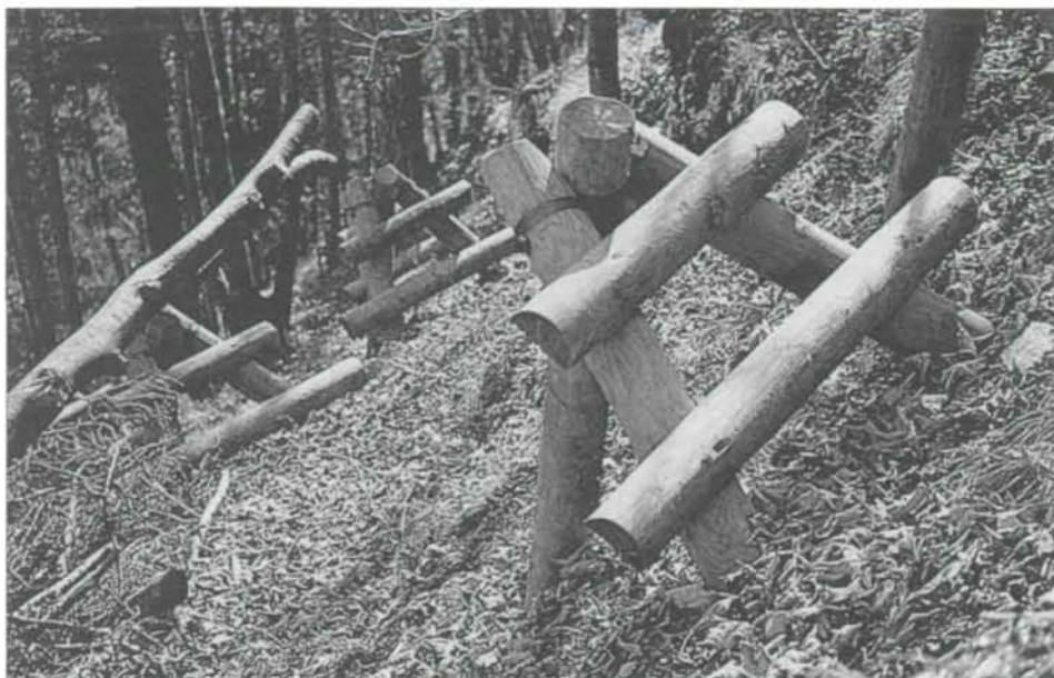
Abb. 8: Verrottbare Baustoffe als technische Hilfsmittel.
