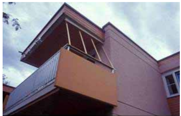
Abb. 4 Einfache Maßnahmen können zum Teil viel bewirken, z.B. den Erhalt eines Spaltenquartiers durch Einbau eines Rollos. Foto: K. Krainer
