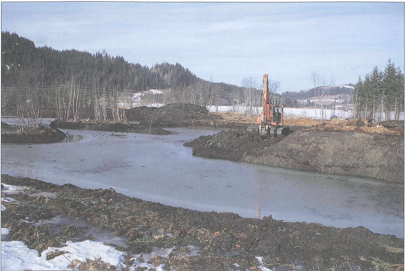
Abb. 5: Baggerung der Wasserfläche auf einer ehemals mit Fichten aufgeforsteten Fläche.
