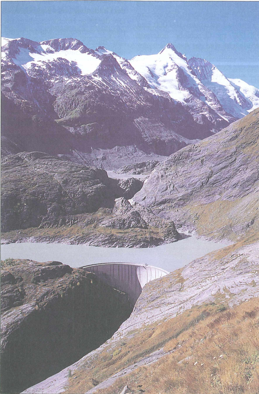
Abb. 2: Beim Margaritzenspeicher beginnt die energiewirtschaftliche Nutzung der Möll. Sein Auslauf stellt den sekundären Ursprung der Möll dar.
