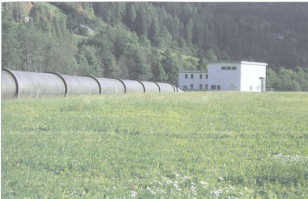
Abb. 3: Verrohrte Ausleitungsstrecke des Kraftwerks Gößnitz flussab des Gößnitzstausees.
