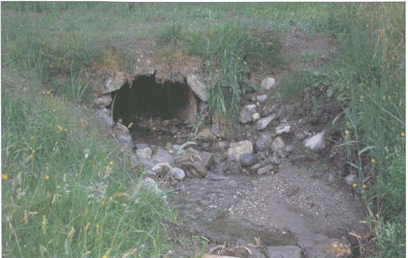
**Abb. 5:** Neuer Rohrdurchlass (zweite Verrohrung) am Stauderbachl, ca. einen Monat nach Baufertigstellung, Mai 2001.
