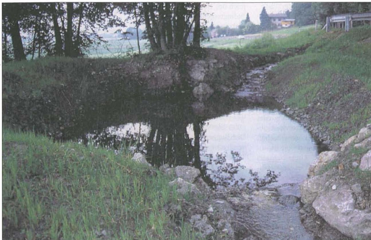
**Abb. 3:** Das Schotterabsetzbecken am Stauderbachl unmittelbar nach der Baufertigstellung, Mai 2001. (Foto: J. Petutschnig)
