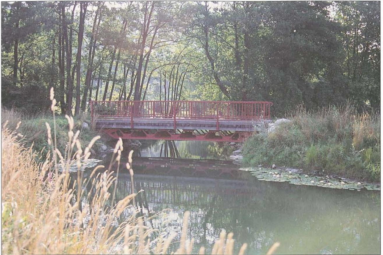
**Abb. 3:** Mit zwei Stahl-Holz-Brücken und einem Rohrdurchlass wurde eine permanente Verbindung zwischen dem Ossiacher Seebach und dem Laichschongebiet hergestellt. (Foto: J. Petutschnig)
