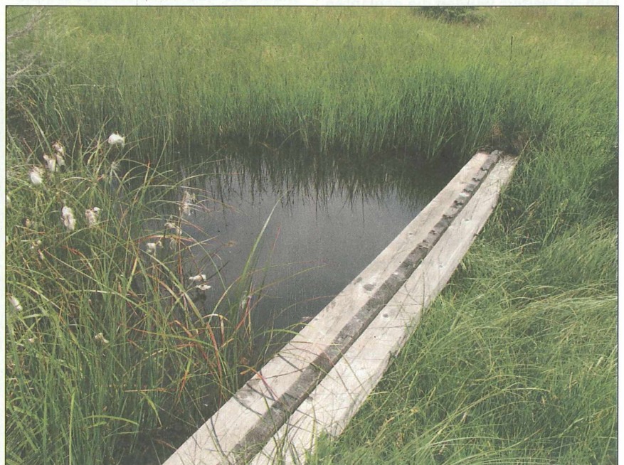
Abb. 6: Aufgestauter Entwässerungsgraben im Überling Moor (Salzburg) 2 Jahre nach Dammeinbau. (Foto: Krainer/Arge NATURSCHUTZ)
