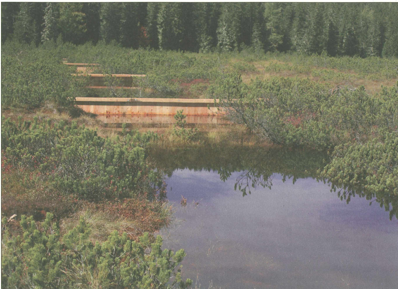
Abb. 11: Wassergefüllte Dämme kurz nach deren Fertigstellung.
