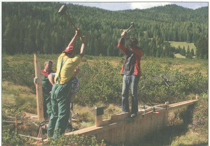
Abb. 8: Einsetzen der Lärchenpfosten.
