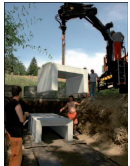
Abb. 6: Einbau eines Kleintier-Durchlasses an der AW 11 Hallegger Straße in Klagenfurt. (Foto: Smole-Wiener/Arge NATURSCHUTZ)
