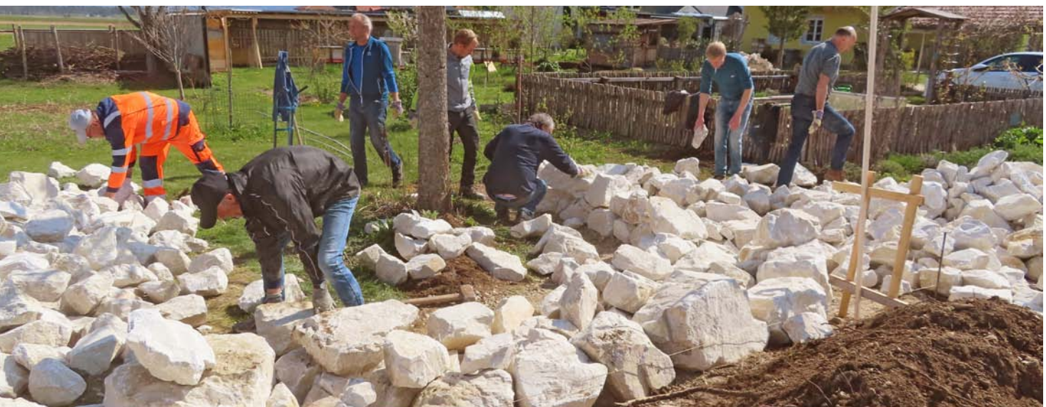
Bau einer Trockensteinmauer im Rahmen einer RNP-Weiterbildungsveranstaltung (Foto: K. Krainer)
