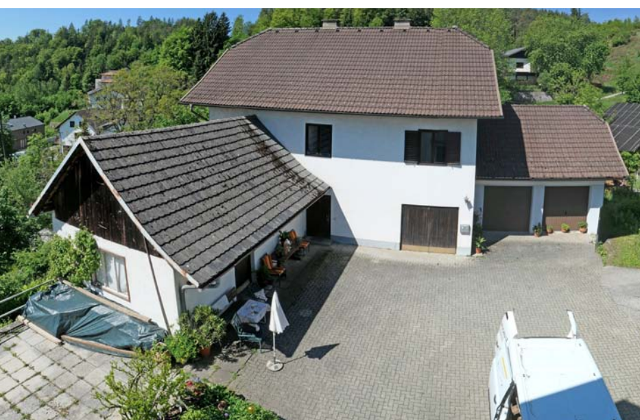
Abb. 2: Gebäudekomplex 7a vor dem Umbau: Wohnhaus (Bildmitte), Frühstücksraum (links) und Garage (rechts) (Foto: K. Krainer)
