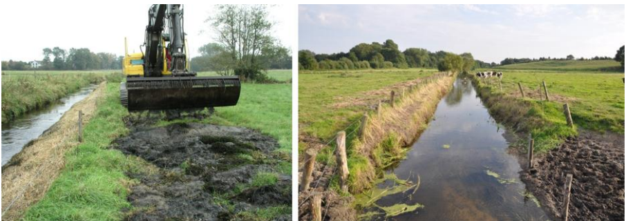
Abb. 1: Beispiele für intensive Gewässerunterhaltung mit Entfernen sämtlicher Strukturen einschließlich der Wasserpflanzen aus den Gewässern durch Räumen mit Baggerschaufel bzw. Mahd mit Mähkorb
