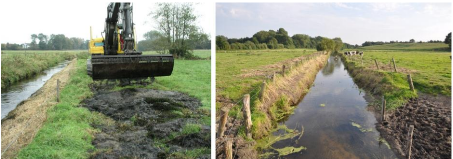
Abb. 1: Beispiele für intensive Gewässerunterhaltung mit Entfernen sämtlicher Strukturen einschließlich der Wasserpflanzen aus den Gewässern durch Räumen mit Baggerschaukel bzw. Mahd mit Mähkorb
