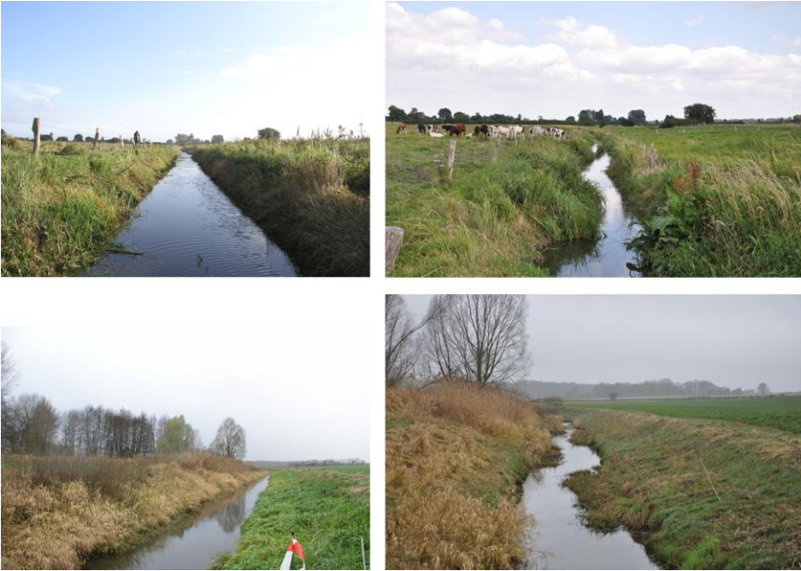
Abb. 8: Entwicklung eines schlängelnden Stromstrichs durch schonende Unterhaltung an zwei der Pilotstrecken – links jeweils nach letztmaliger intensiver Unterhaltung in 2009 und rechts nach 4-maliger Stromstrichmähd Herbst 2013 (oben) bzw. Frühjahr 2014 (unten)
