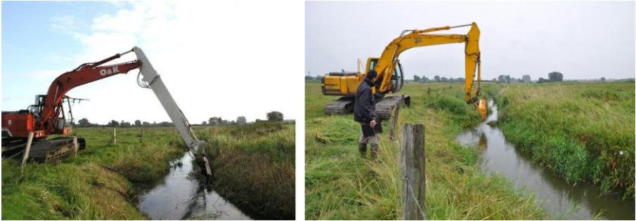
Abb. 7: Gewässerunterhaltung an einer der Pilotstrecken mit dem Mähkorb: Letztmalige intensive Unterhaltung mit beidseitiger Böschungsmahd und kompletter Sohlmahd in einem Arbeitsgang (links) sowie schonende 1-seitige Böschungsmahd und Stromstrichmahd (rechts)
