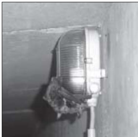
Paarungsquartier Großer Mausohren in einer Kärntner Hohlkastenbrücke
