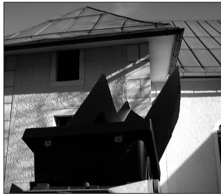
Die Scheinwerferblende schattet den Ausflüglbereich der Fledermäuse ab.
