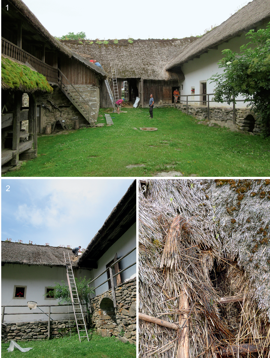
Abb. 1-3: (1) Innenhof des Mittermayrhofs in Pelmburg; (2) Entnahme von Stroh an der Nordostecke des Daches durch den Erstautor; (3) Schichtung des unterschiedlich zersetzten Strohs in der Südwestecke.
