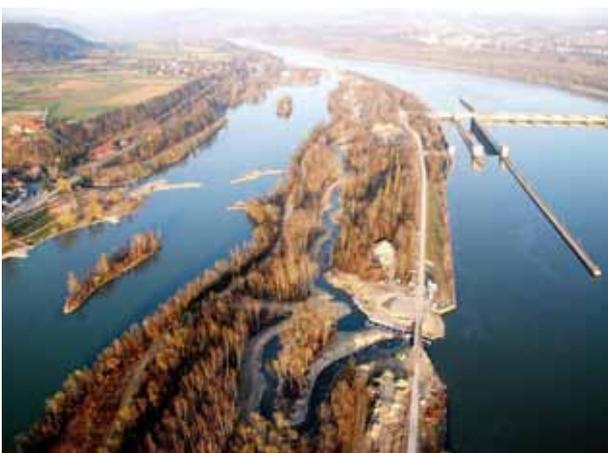
*Fischwanderhilfe KW Melk, im Vordergrund das Dotationsbauwerk ©AHP*
