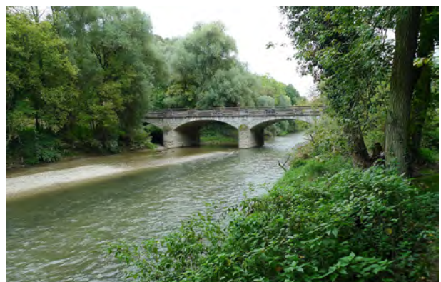
Brücke an der Pielachmündung
