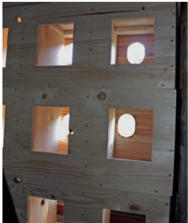
Innenansicht der Nistanlage, deren Wartungsöffnungen innen mit verschraubten Verbundholzplatten verschlossen wurden.
