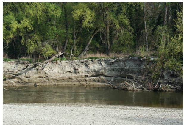
Neues Prallufer in der Pritzenau. Foto: H. Seehofer
