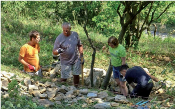
Reparatur einer Trockenmauer. Foto: N. Stahl
