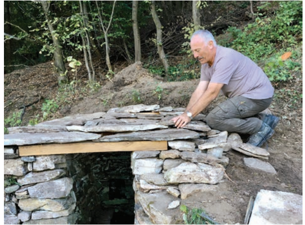
Josef Pennerstorfer beim Einrichten der Deckplatten. Foto: A. Wenger
