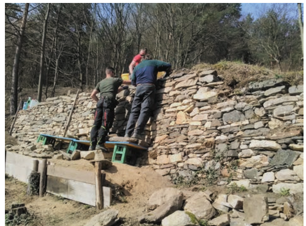
Kursteilnehmer des zweiten Trockenmauerkurses bei der Wiederherstellung eines großen Mauerabschnittes. Foto: H. Seehofer
