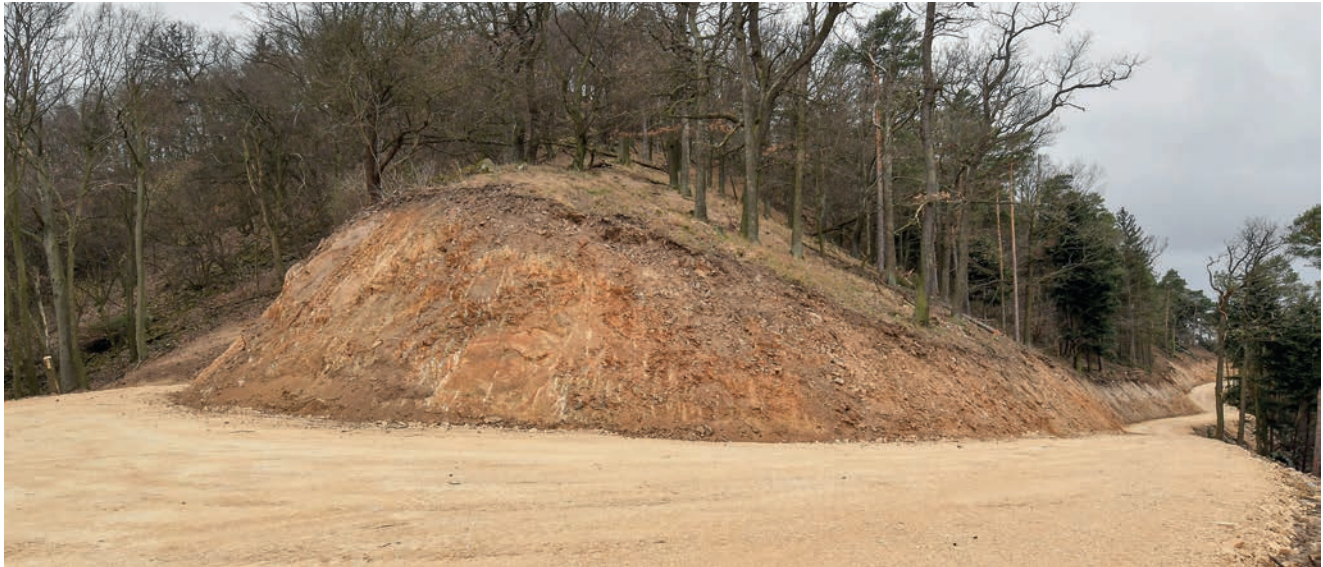
Abb. 2: Neue Forststraße am Südhang des Waxenbergs.
